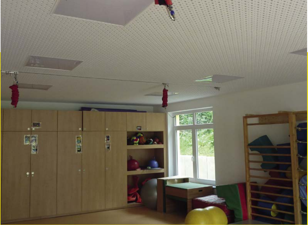
Schallabsorbierende Decke in einem Mehrzweckraum
