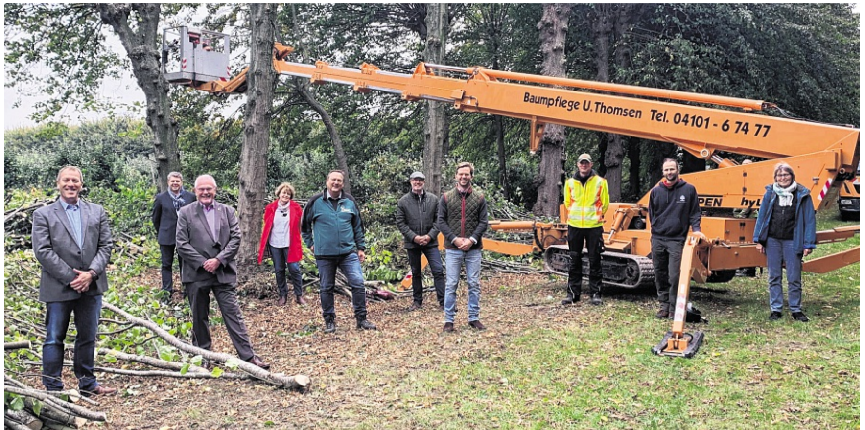
Sie haben sich für den Erhalt der historischen Linden-Doppelallee eingesetzt. Am 2. Oktober konnten die Baumpflegearbeiten beginnen.
