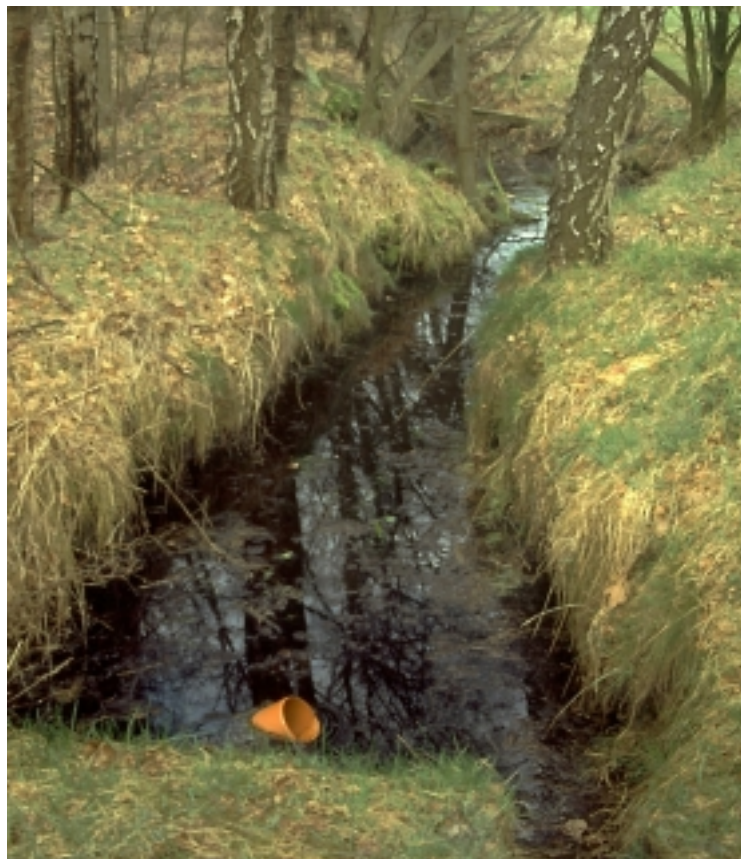
Einfache, aber wirksame Anstaumaßnahme im Holm Moor mit regulierbarem „Kniegelenk“ eines Plastikrohres.
